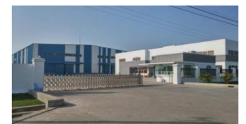
미얀마 포스코강판 전경
