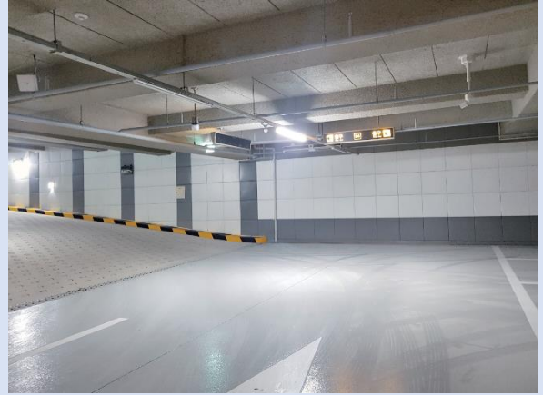
▲포스코강판의 불연컬러강판으로 시공한 공동주택 지하 벽체 배수판
