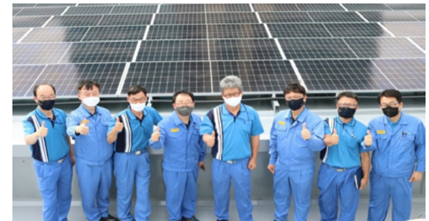
본사 옥상 지붕형 태양광 발전 설비 가동식
