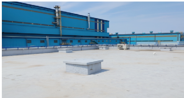
태양광 발전 설치 구축 전
