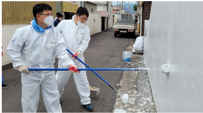
▲ 취약계층 주거환경 개선 도색 작업 모습
